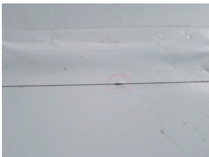
Obr. č. 6 Lokalizovaná netesnosť 6 na spoločnej atike RD2 a RD3
